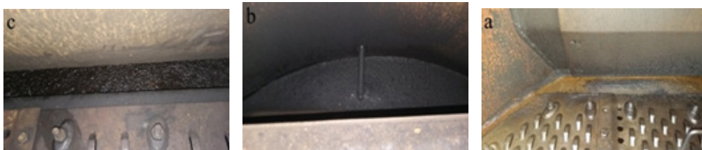
شکل ۵ تجمع حجم زیادی از رسوبات در ناودانی
