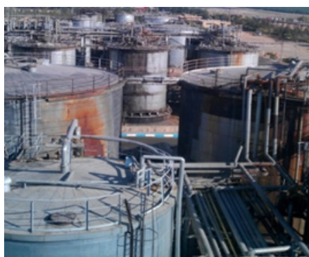
شکل ۱ مخازن ذخیره‌سازی قطران زغال‌سنگ در پالایشگاه Fig. 1 Coal tar storage tanks at the refinery
